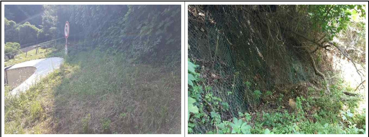
【 갭구부 사면 전경 사진 】
