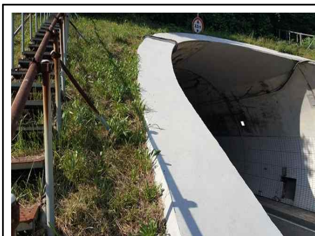
갭문 보수 상태양호
