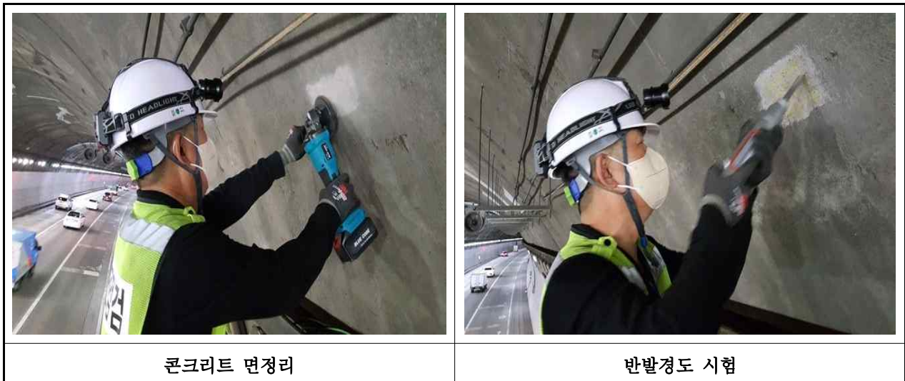
【 콘크리트 반발경도 조사 사진 】
