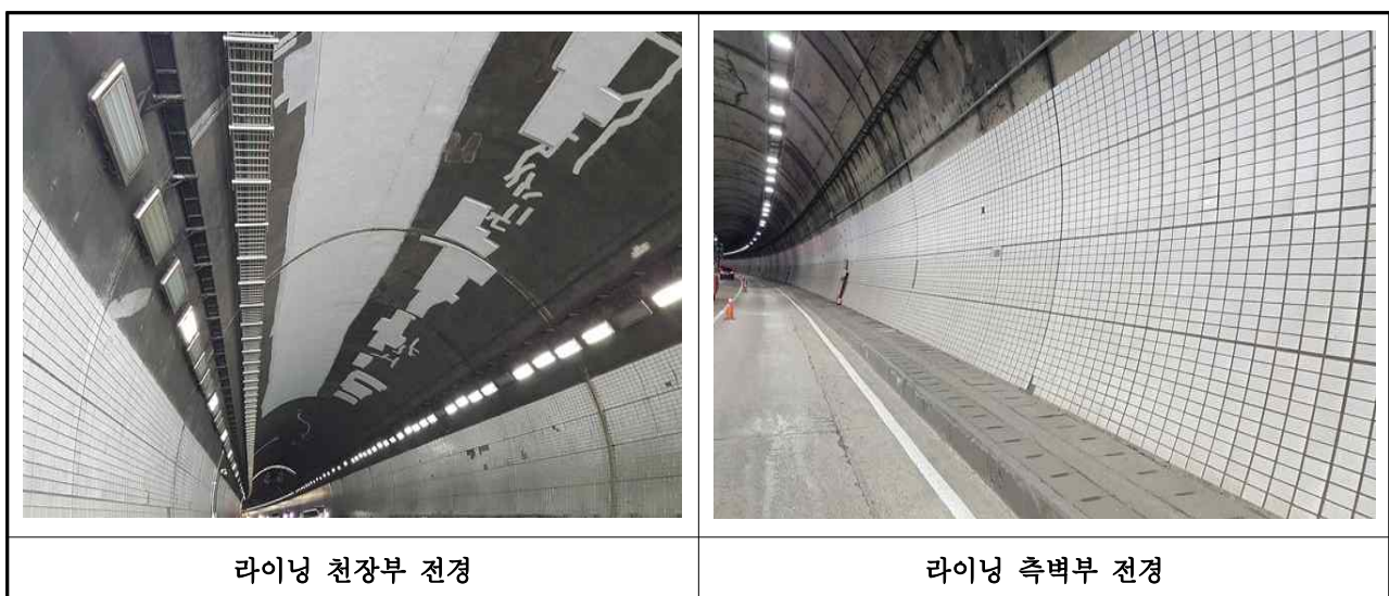
【 터널 라이닝 전경 】
