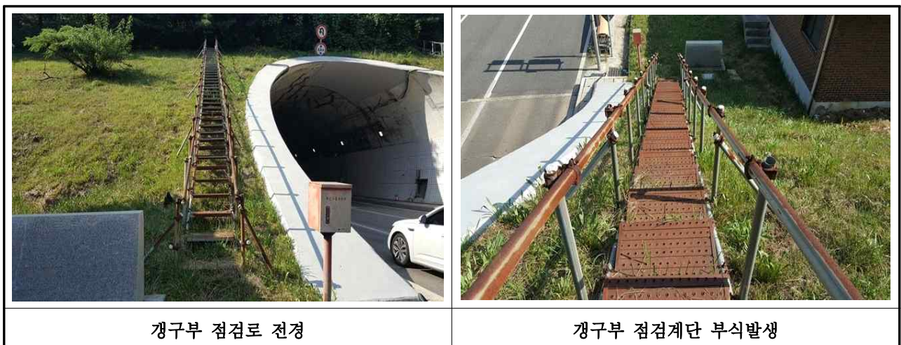
【 추락방지시설 외관조사 사진 】
